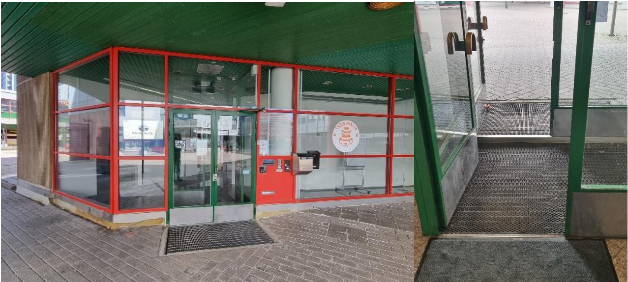
Kuva 3: Pääsisäänkäynnin edusta ja ovet ulkoa ja sisältä (huom. kynnykset)
